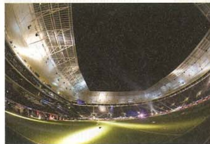
In der Rhein-Neckar-Arena öffnen die Türen über eine elektronische Berechtigung. Bild: vaf-foto
