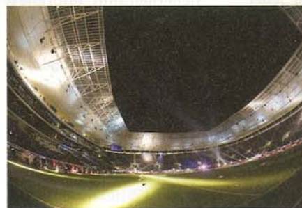
In der Rhein-Neckar-Arena öffnen die Türen über eine elektronische Berechtigung. Bild: vaf-foto
